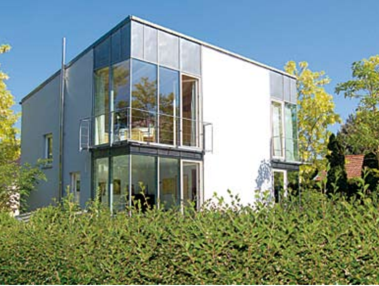
Moderne Ausstrahlung: Betriebs- und Verwaltungsgebäude von Freier Landschaftsbau in Schondorf
